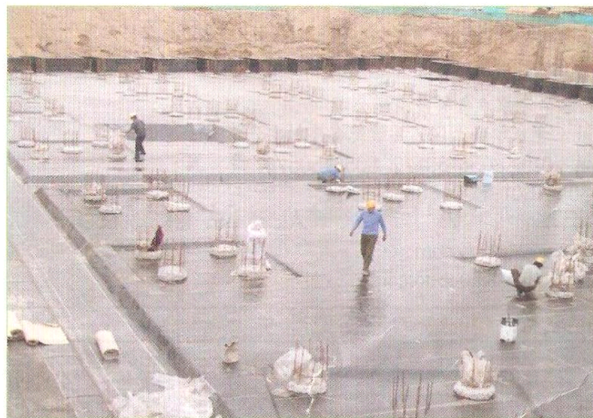
BAC 卷材地下室防水施工
